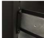
Рис. 1b. Монтаж у стійку
